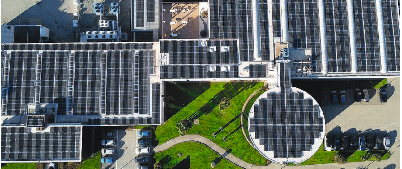
Photovoltaik (PV) am Konzernsitz im Tessin
